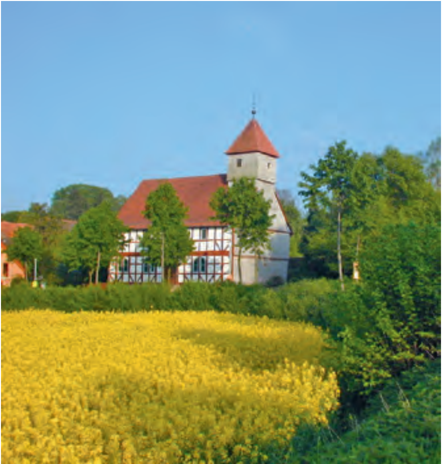
Die Hugenottenkirche in Carlsdorf. Erbaut 1699-1704 auf den Grundmauern einer mittelalterlichen Kapelle (Foto: Evangelische Kirche Hofgeismar).
