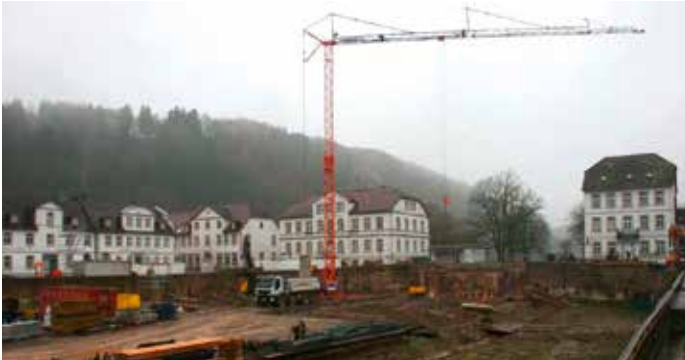
Die Großbaustelle am historischen Hafen in Bad Karlshafen 2018.
