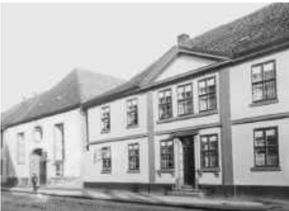
Die 1973 abgerissene Hugenottenkirche in Hameln (links) mit dem noch existierenden ehemaligen Pfarrhaus – heute „Hugenottenhaus“, das auf dem Rundgang gezeigt wird (Foto: Stadtarchiv Hameln).
